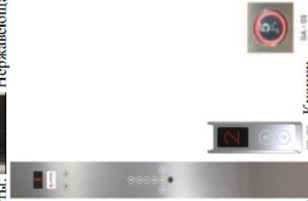
Приказная и вызывные панели лифта, индикация:
