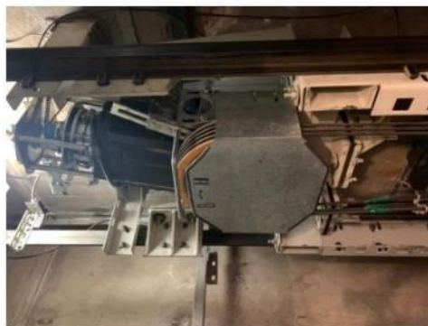
На фото внешний вид лебедки главного привода
