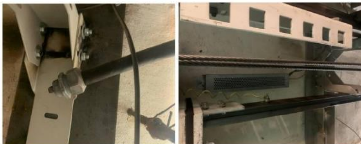
На верхнем фото не подключенный механизм штурвала для перемещения кабины из шкафа управления Лифта № 3. Зав. № 174797
