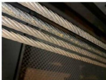
На правом фото показан износ тяговых канатов вследствие коррозии. Лифта № 4. Зап. № 174808
