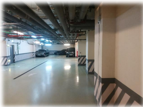
Фотография 3.5. Внутреннее состояние помещений подземного этажа
