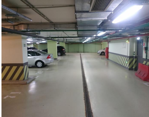
Фото 7. Фрагменты внутренних помещений подземного этажа
