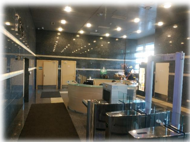
Фотография 3.9. Внутреннее состояние помещений 1 этажа
