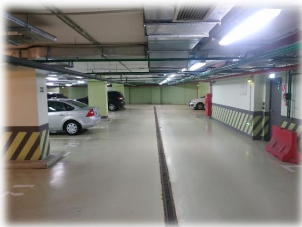
Фотография 3.7. Внутреннее состояние помещений подземного этажа
