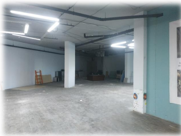
Фотография 3.12. Внутреннее состояние помещений 1 этажа
