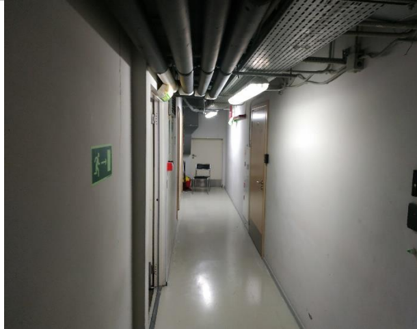
Фото 43. Фрагменты внутренних помещений технического этажа
