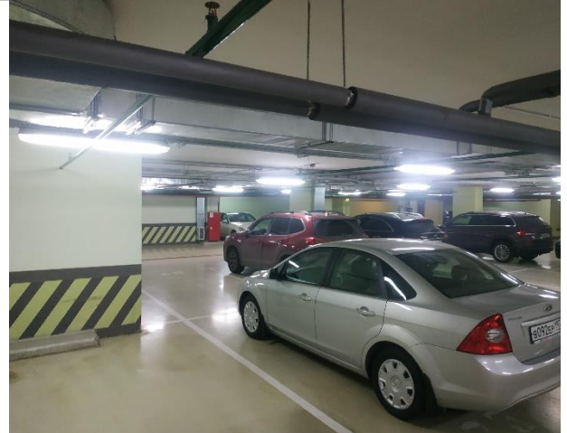
Фото 8. Фрагменты внутренних помещений подземного этажа
