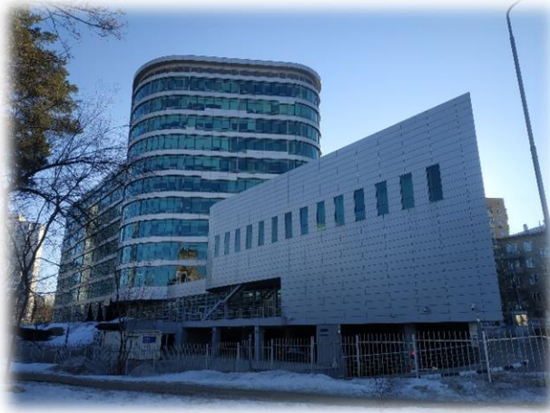
Фотография 3.1. Фасад здания
