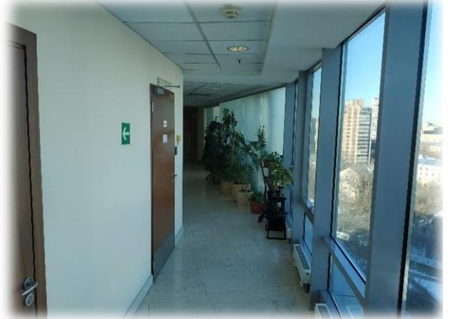
Фотография 3.14. Внутреннее состояние помещений 10-11 этажей
