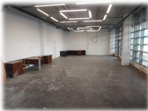
Фотография 3.10. Внутреннее состояние помещений 1 этажа
