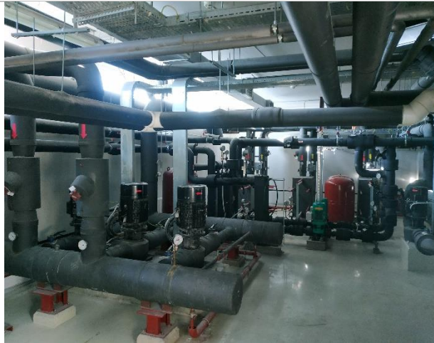
Фото 45. Фрагменты внутренних помещений технического этажа
