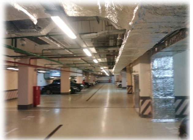
Фотография 3.6. Внутреннее состояние помещений подземного этажа
