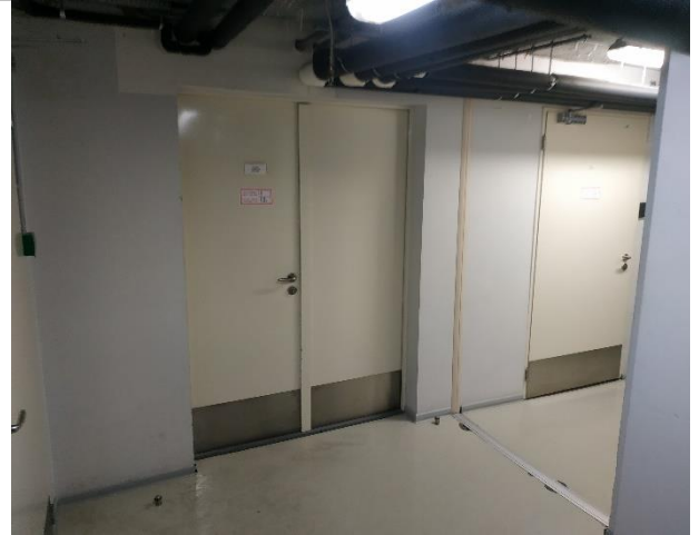
Фото 44. Фрагменты внутренних помещений технического этажа
