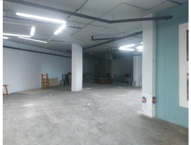
Фото 20. Фрагменты внутренних помещений 1 этажа
