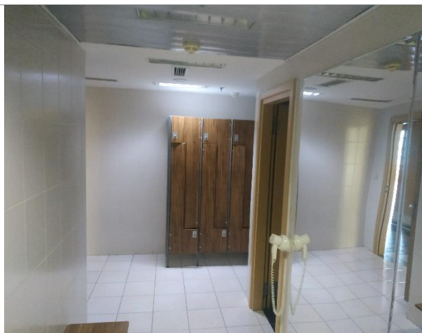
Фото 17. Фрагменты внутренних помещений 1 этажа
