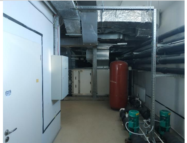
Фото 46. Фрагменты внутренних помещений технического этажа
