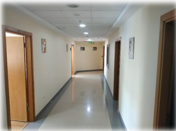
Фотография 3.17. Внутреннее состояние помещений 10-11 этажей
