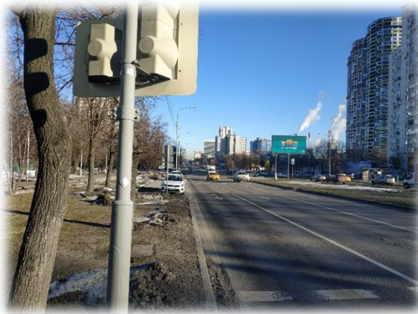
Фотография 3.3. Вид подъездных путей к зданию
