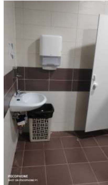
Фото № 49. Нежилое помещение
