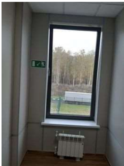
Фото № 7. Нежилое помещение
