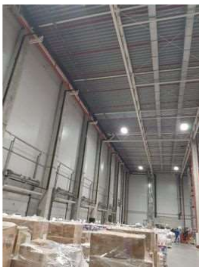
Фото № 9. Нежилое помещение
