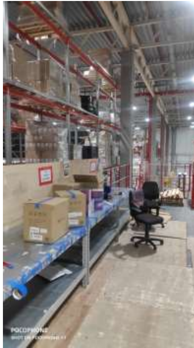
Фото № 36. Нежилое помещение
