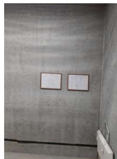
Фото № 6. Нежилое помещение
