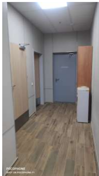
Фото № 46. Нежилое помещение
