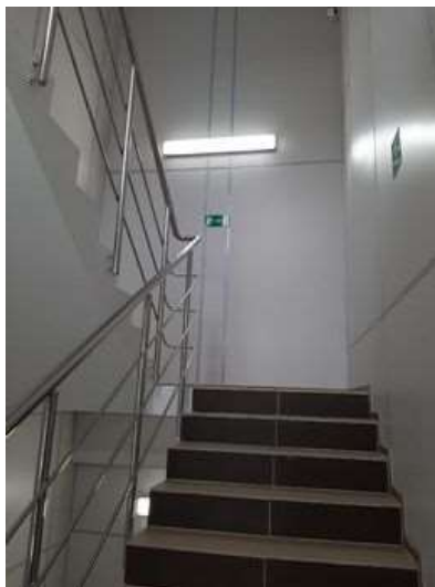
Фото № 8. Нежилое помещение
