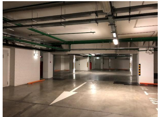
Подземный паркинг (на -4 этаже)
