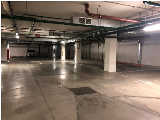
Подземный паркинг (на -5 этаже)
