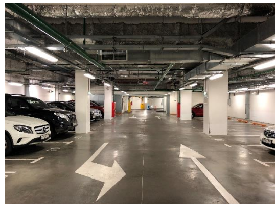
Подземный паркинг (на -1 этаже)
