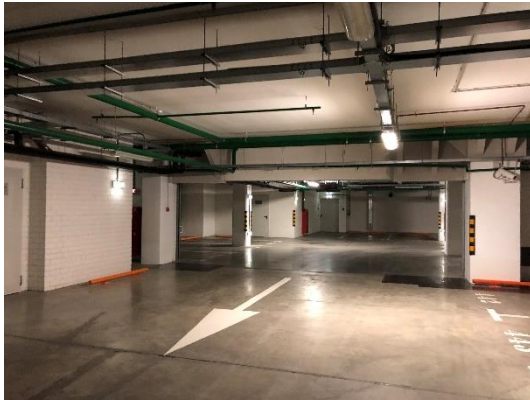
Подземный паркинг (на -4 этаже)
