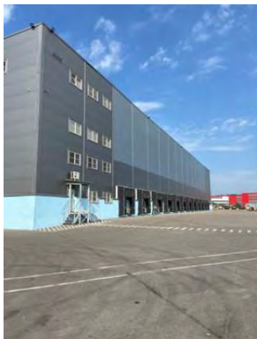
Фото № 5. Фасад здания
