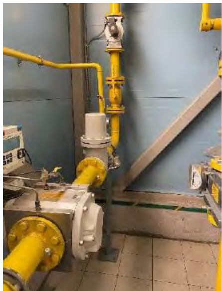
Фото № 27. Нежилое помещение
