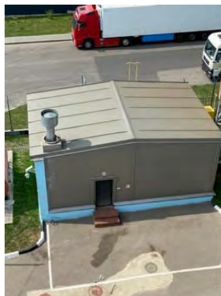
Фото № 24. Общий вид здания котельной
