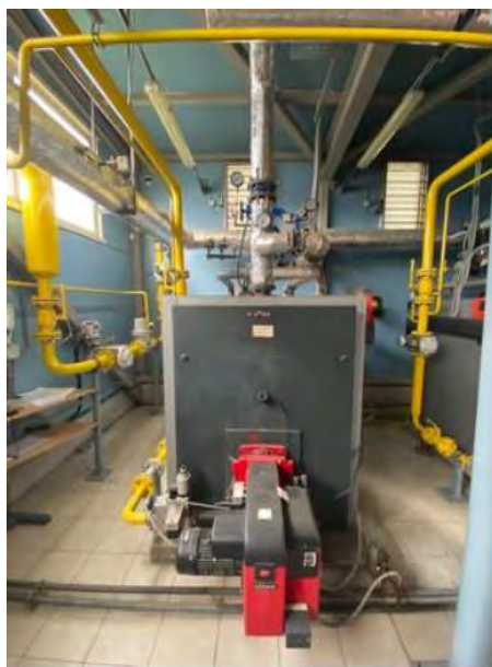
Фото № 26. Нежилое помещение
