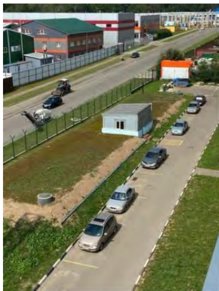
Фото № 21. Общий вид здания насосной
