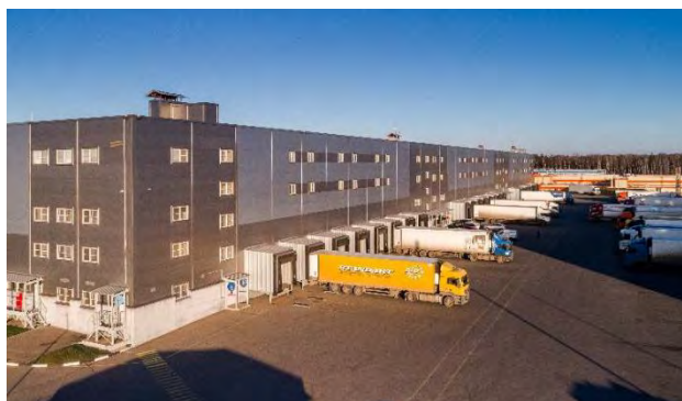
Фото № 2. Общий вид складского комплекса
