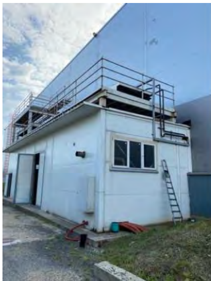
Фото № 19. Помещение компрессорной
