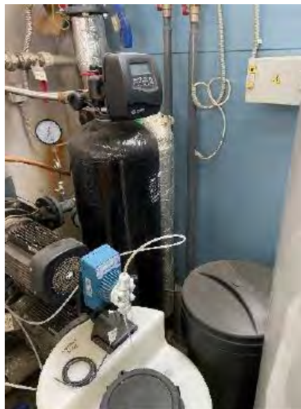
Фото № 28. Нежилое помещение
