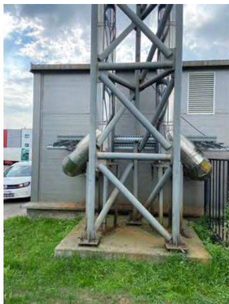
Фото № 25. Общий вид здания котельной
