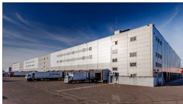
Фото № 4. Фасад здания
