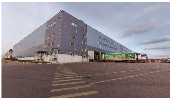
Фото № 3. Фасад здания
