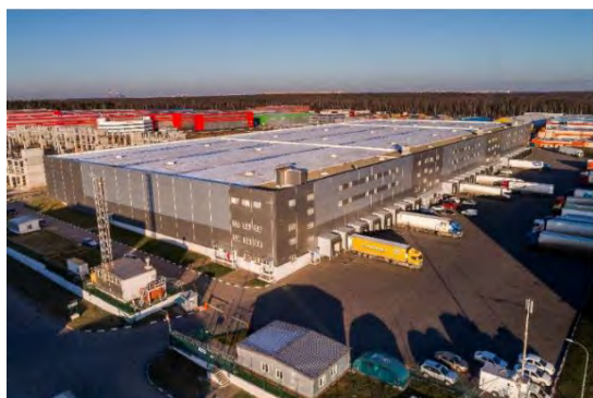
Фото № 1. Общий вид складского комплекса
