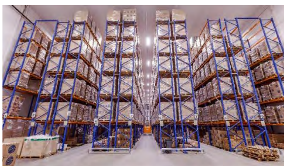
Фото № 7. Нежилое помещение склада
