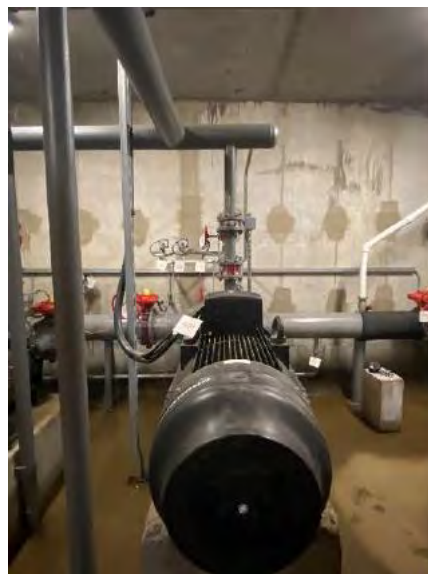
Фото № 22. Нежилое помещение
