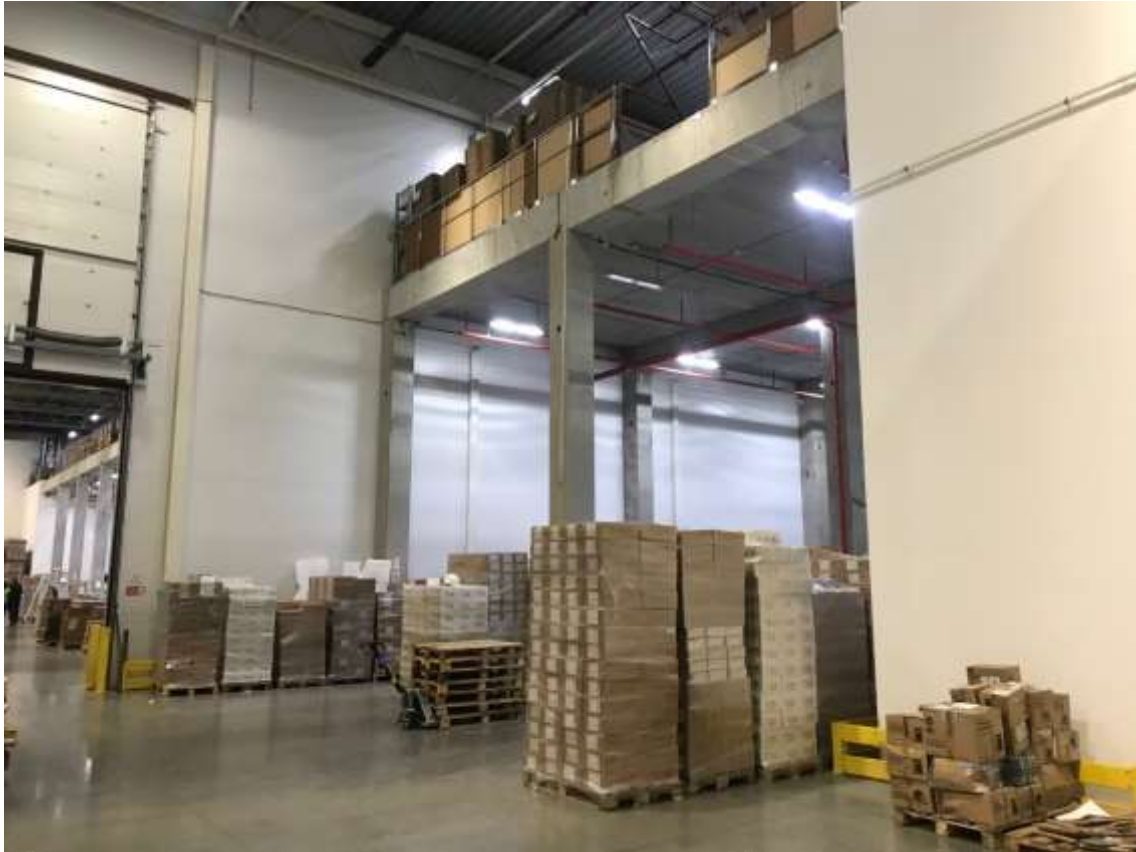
Фото № 11. Нежилое помещение оцениваемого здания
