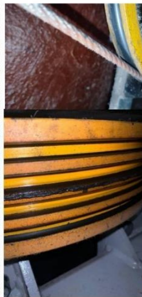
На правом фото показан износ тяговых канатов вследствие коррозии. Лифт № 4, Зав. № 174808
