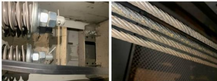
На правом фото показан износ тяговых канатов вследствие коррозии. Лифт № 4, Зав. № 174808
