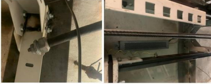
На верхнем фото не подключенный механизм игурвала для перемещения кабины из шкафа управления. Лифта № 3. Зав. № 174797
